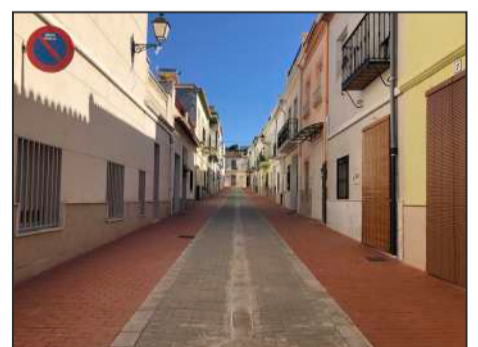
Canvi de fibrocement i pavimentació de carrers 274.293,35 €
