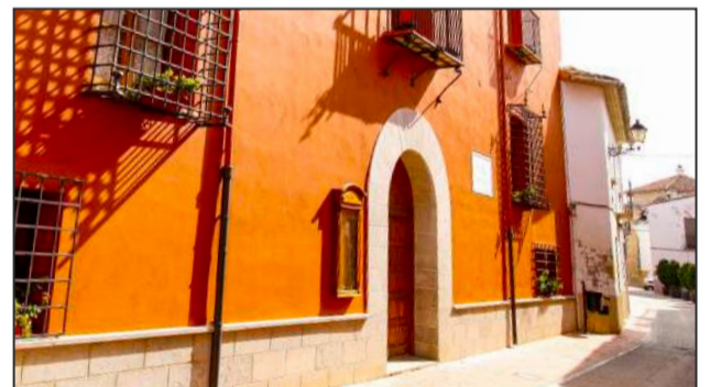
Ajuntament Reforma i accessibilitat (ascensor) 93.464,86 €
