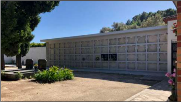
Cemeteri municipal Construcció de pàrking i nínxols 98.380,49 €
